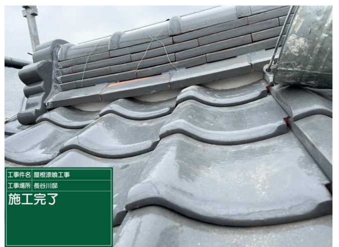
34 大屋根 漆喰 施工完了
