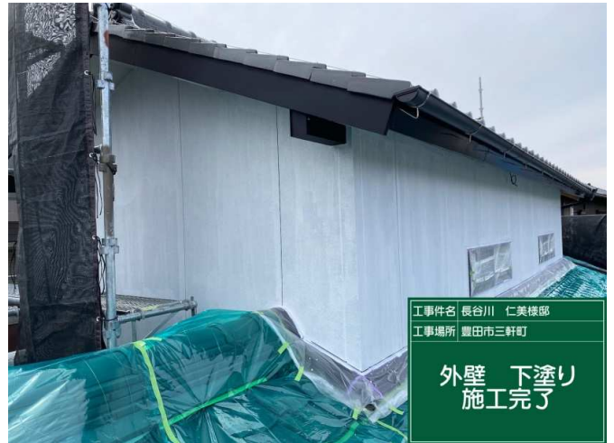
20 外壁2F 下塗り 施工完了
