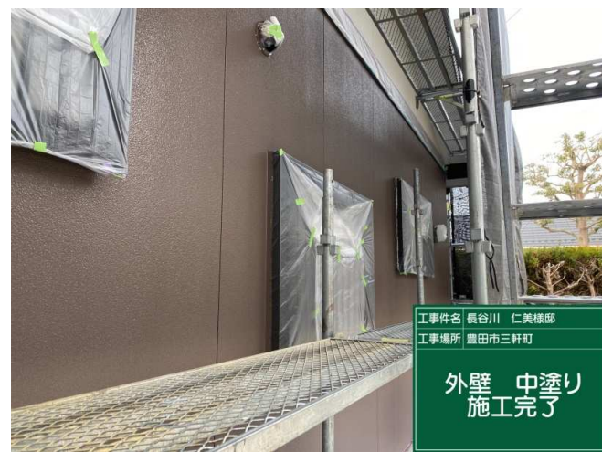
16 外壁1F 中塗り 施工完了
