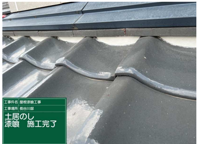
44 土居のし 漆喰 施工完了
