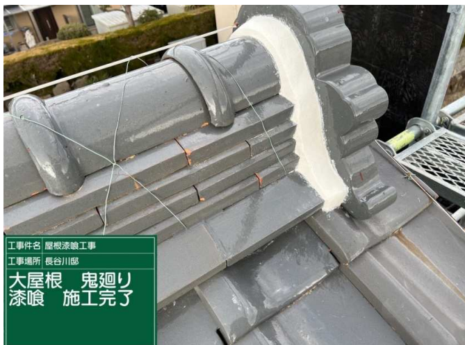
39 鬼廻り 漆喰 施工完了
