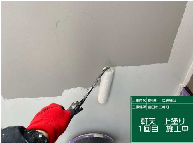
9 軒天 上塗り 1回目 施工中
