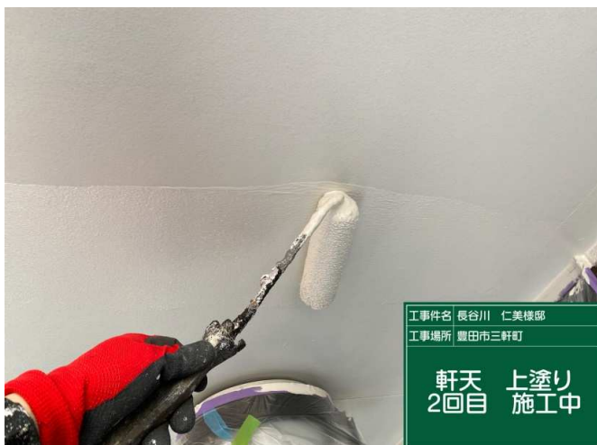
11 軒天 上塗り 2回目 施工中
