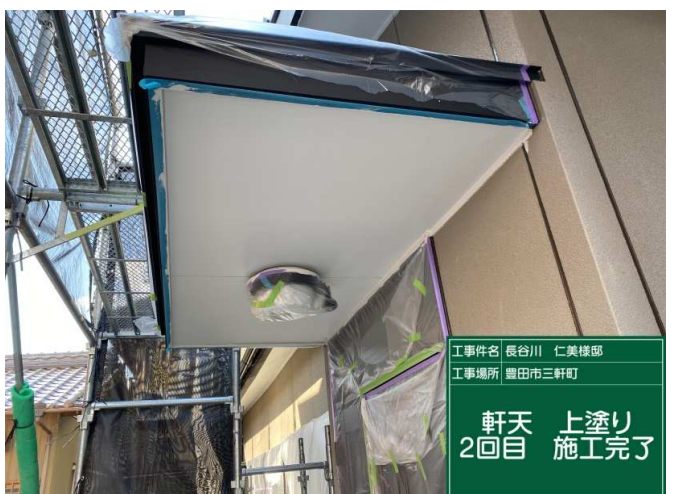
12 軒天 上塗り 2回目 施工完了
