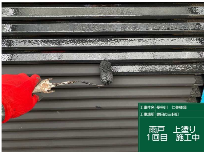
27 雨戸 上塗り 1回目 施工中
