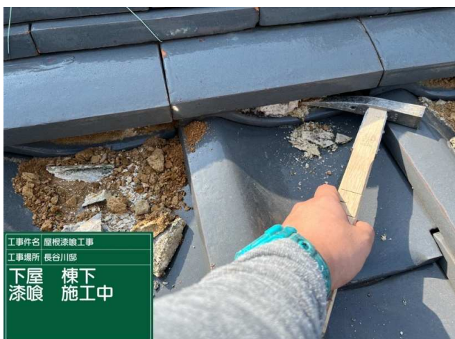
41 下屋 既設漆喰撤去 施工中
