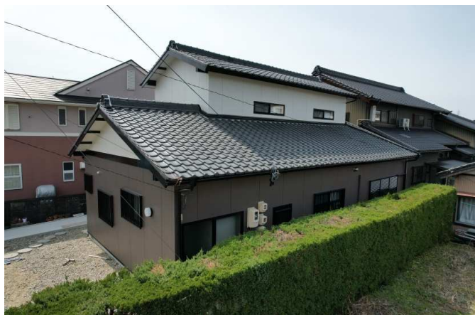
56 施工完了(ドローン撮影)
