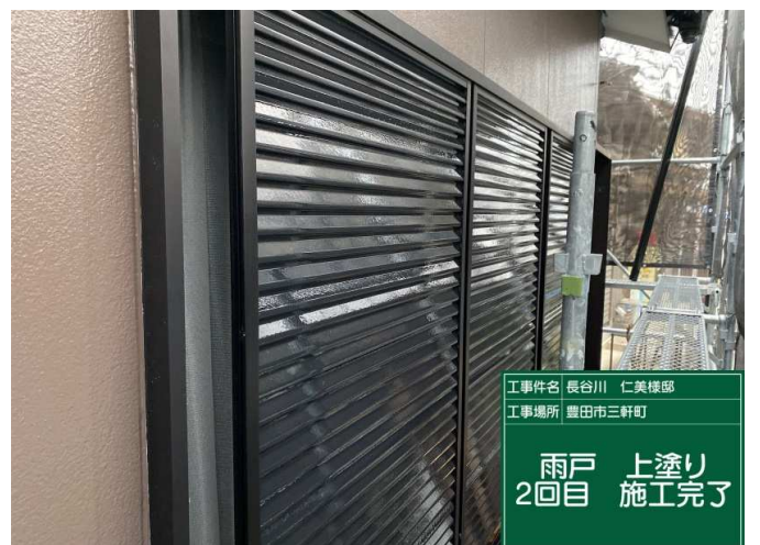
30 雨戸 上塗り 2回目 施工完了
