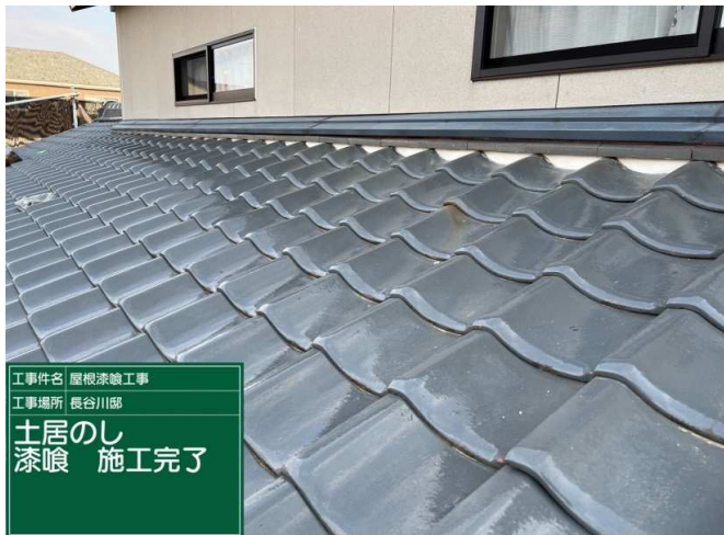
45 土居のし 漆喰 施工完了
