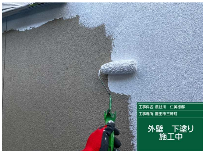
13 外壁1F 下塗り 施工中
