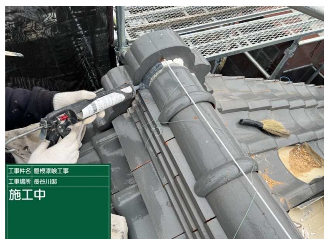
36 鬼廻り コーキング 施工中
