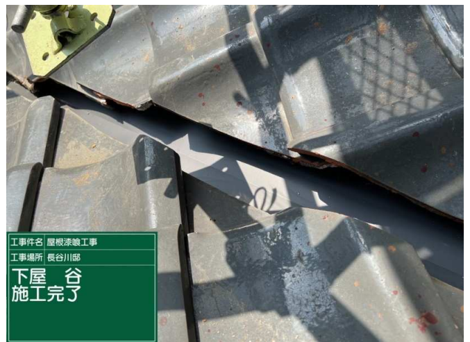
52 下屋 谷樋 施工完了
