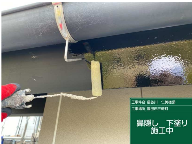
23 鼻隠し 下塗り 施工中
