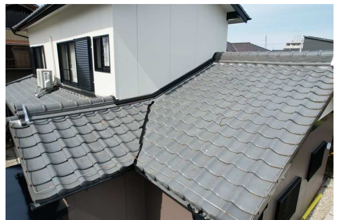
54 施工完了(ドローン撮影)
