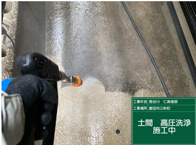
3 土間 高圧洗浄 施工中
