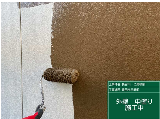
15 外壁1F 中塗り 施工中
