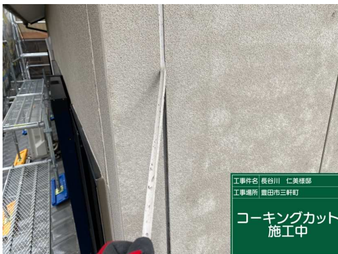
5 既設コーキング 撤去 施工中
