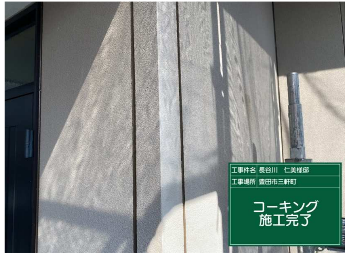
8 コーキング 施工完了
