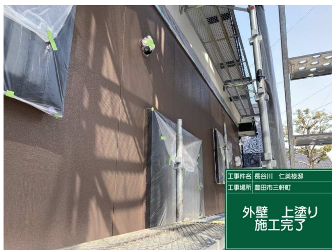
18 外壁1F 上塗り 施工完了
