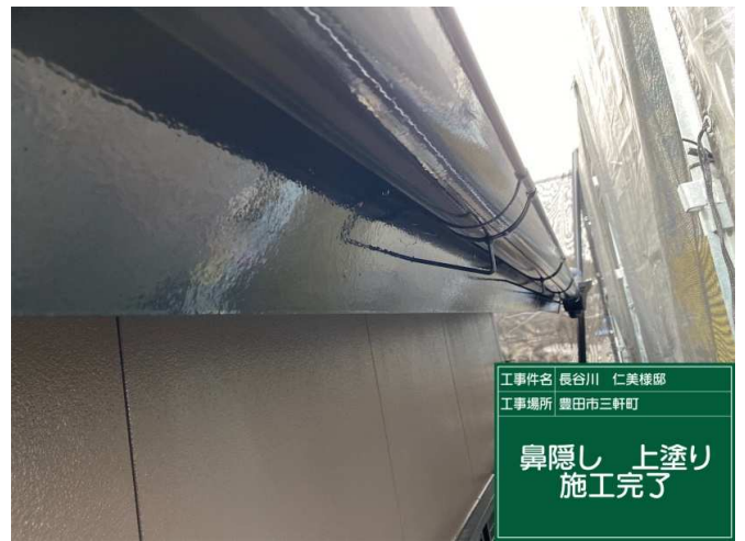
26 鼻隠し 上塗り 施工完了
