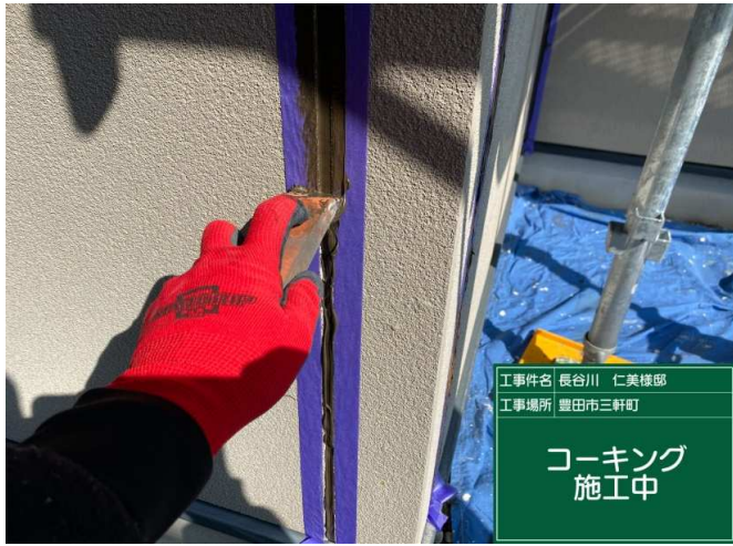
7 コーキング 施工中
