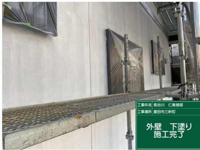
14 外壁1F 下塗り 施工完了
