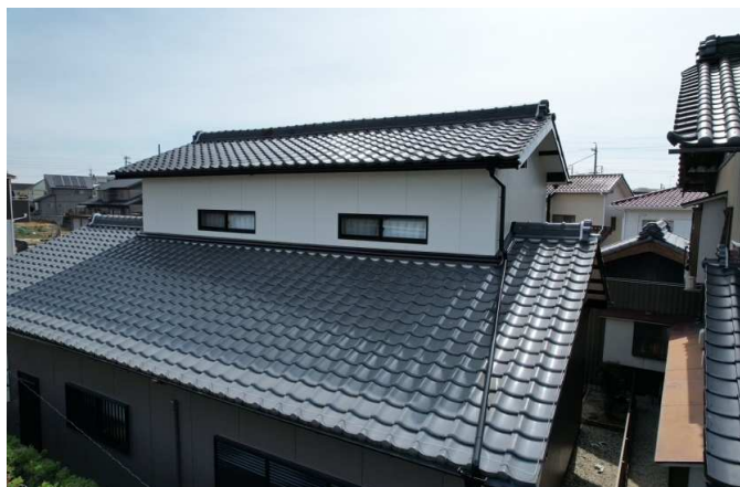
55 施工完了(ドローン撮影)
