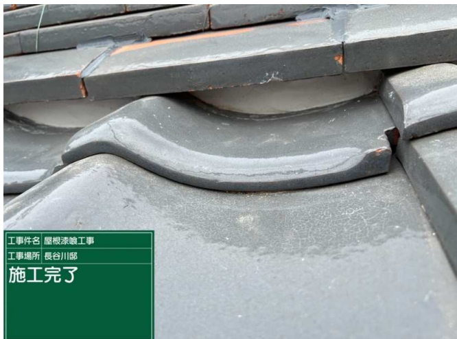
33 大屋根 漆喰 施工完了
