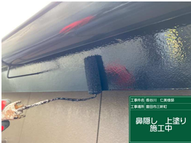
25 鼻隠し 上塗り 施工中
