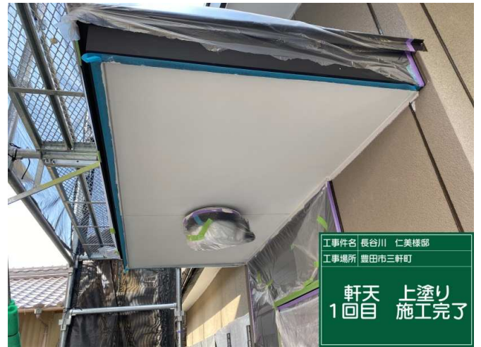
10 軒天 上塗り 1回目 施工完了
