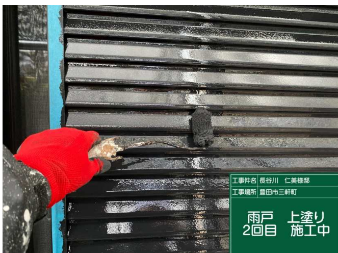
29 雨戸 上塗り 2回目 施工中
