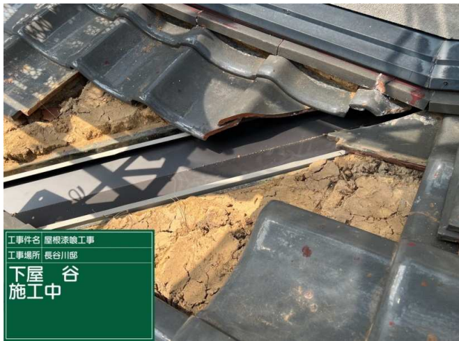
49 下屋 谷樋 施工中
