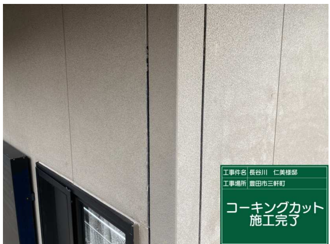
6 既設コーキング 撤去 施工完了
