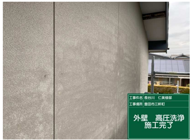
2 外壁 高圧洗浄 施工完了
