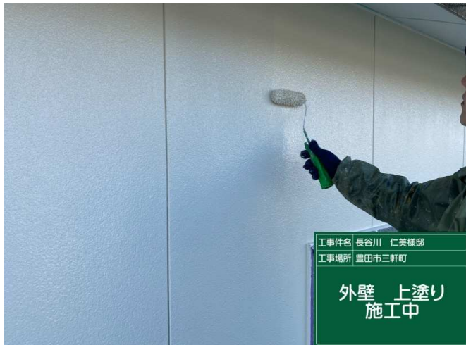
21 外壁2F 上塗り 施工中 (中塗りの写真を撮り忘れてしまいました)
