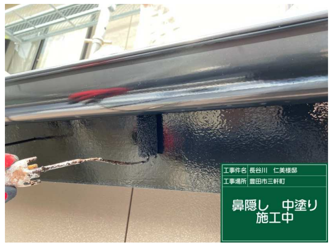
24 鼻隠し 中塗り 施工中
