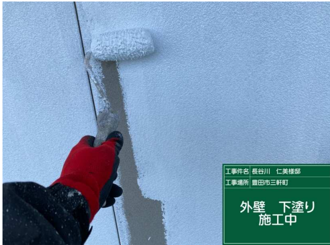
19 外壁2F 下塗り 施工中
