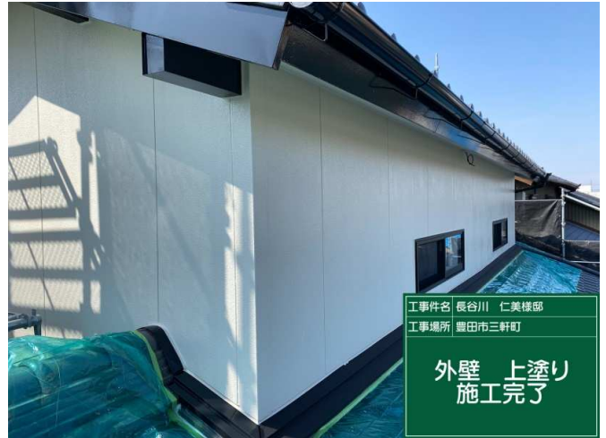
22 外壁2F 上塗り 施工完了
