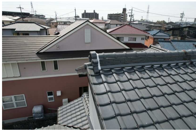
58 施工完了(ドローン撮影)
