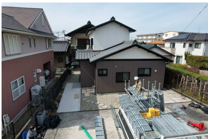
53 施工完了(ドローン撮影)
