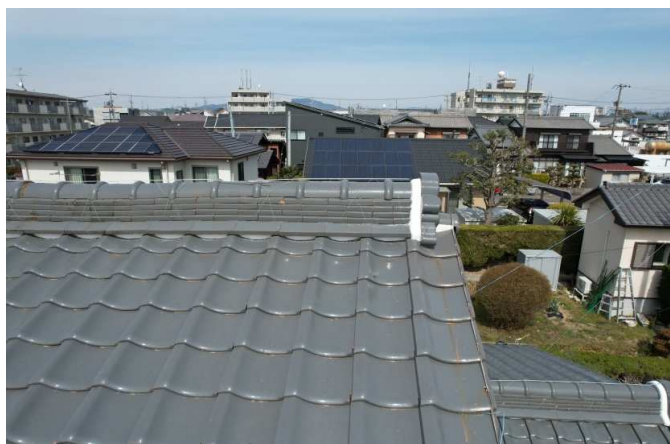
57 施工完了(ドローン撮影)
