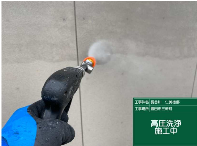
1 外壁 高圧洗浄 施工中
