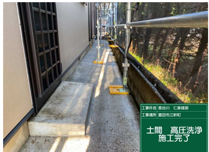
4 土間 高圧洗浄 施工完了
