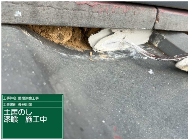
43 土居のし 漆喰 施工中
