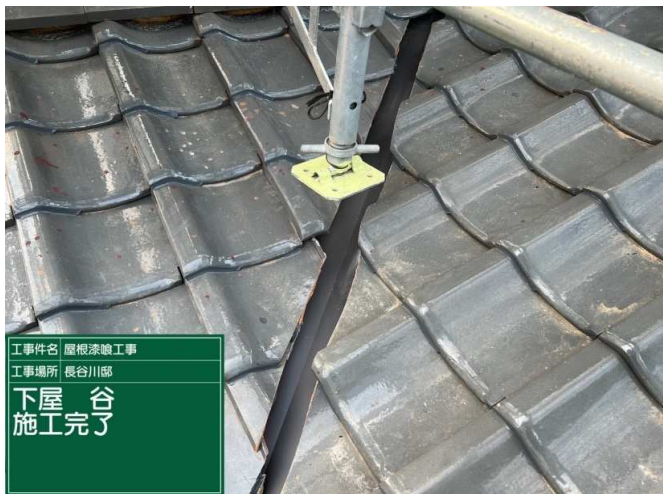
51 下屋 谷樋 施工完了
