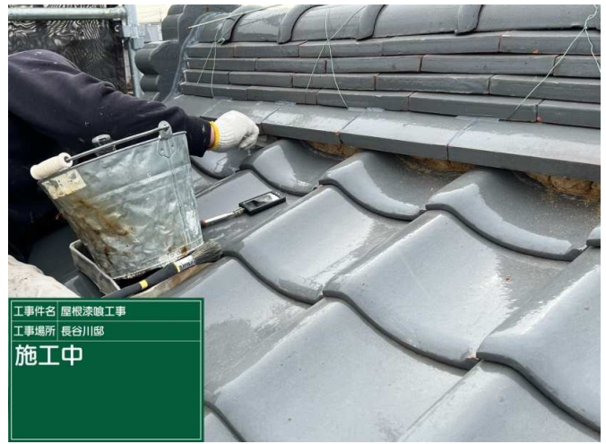
32 大屋根 漆喰 施工中
